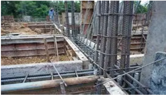
Gambar 1.4 Rangka Besi tidak Berkarat
